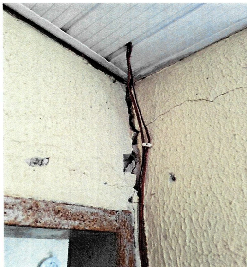
Fotos 04: Vista Interna - sala.
