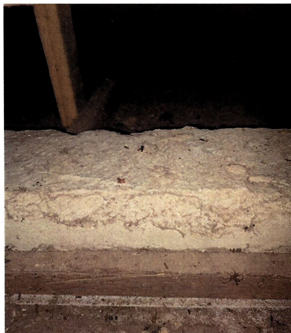
Fotos 16: Vista sobre o forro – Cinta / Viga.
