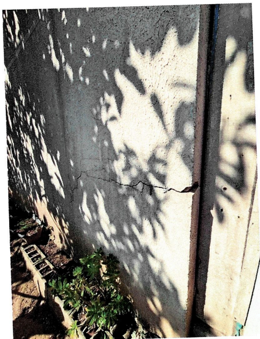
Fotos 09: Vista externa - Lateral.
