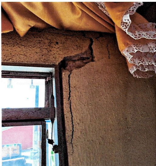
Fotos 03: Vista Interna - sala.
